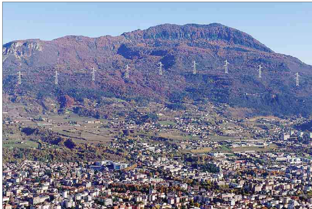
Il rendering del progetto di elettrodotto di Terna ai piedi della Marzola
